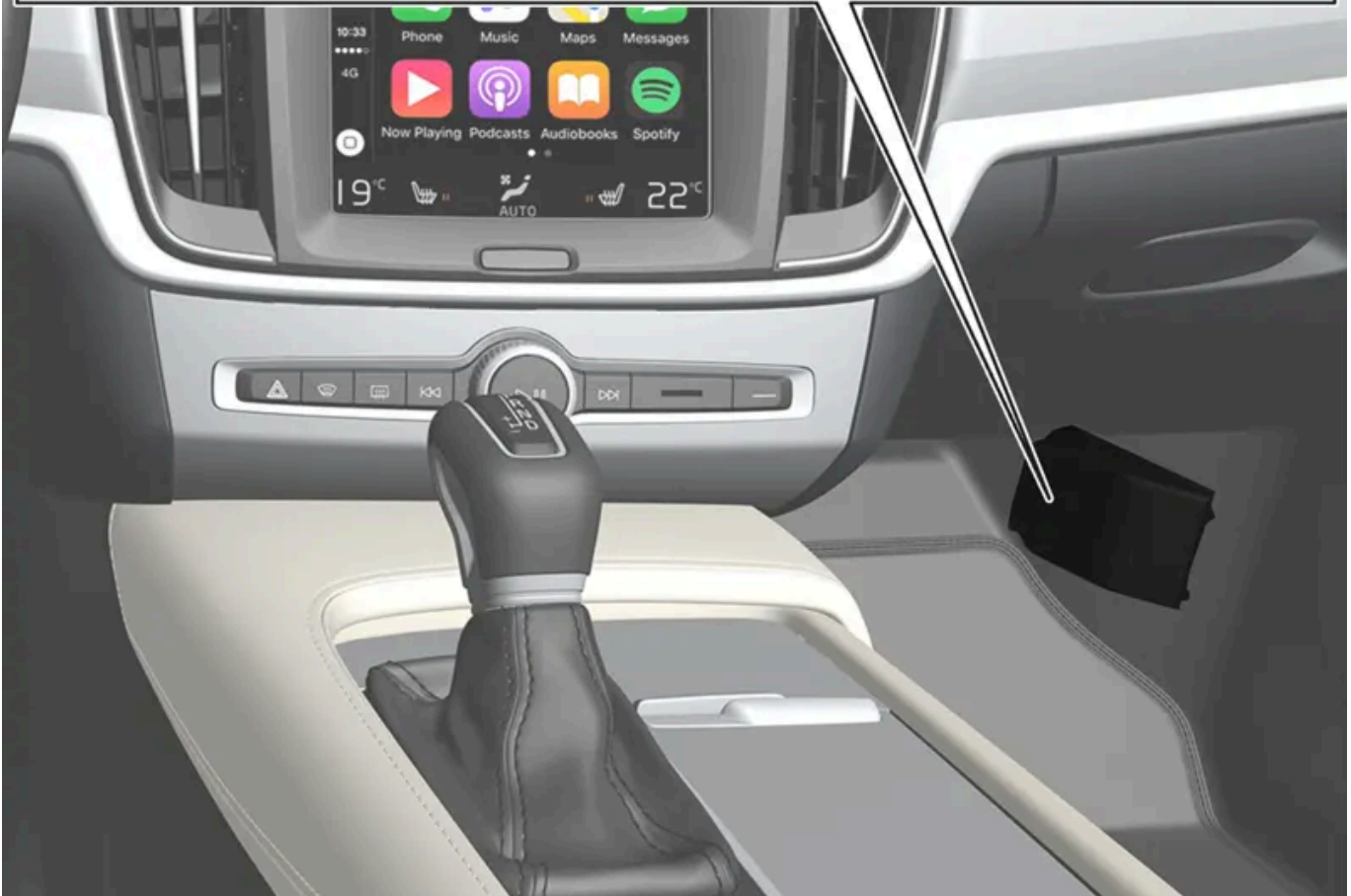
Der Sicherungskasten befindet hinter der Bodenmatte/Seitenverkleidung.
