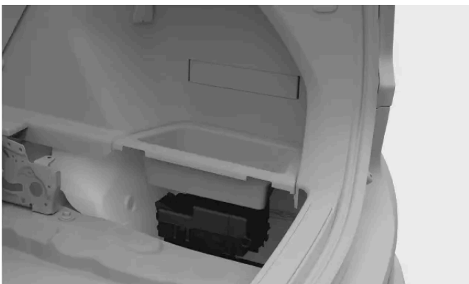
Emplacement de la boîte à fusibles
